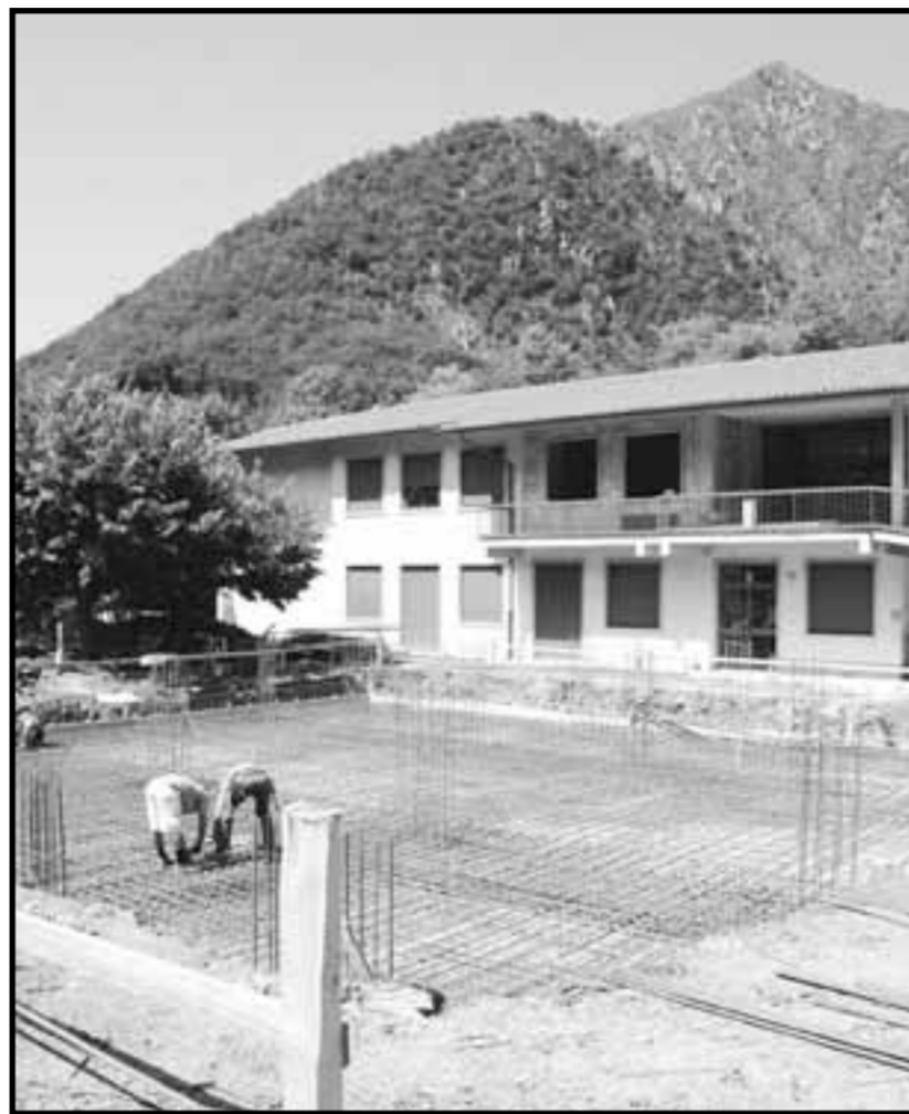
Lavori in corso alle scuole di Ambria (foto Andreato)
